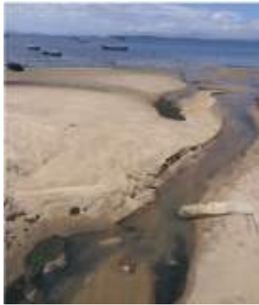
Rede mista desagua na praia de Olaria em local de lazer – desague na Baía de Guanabara
