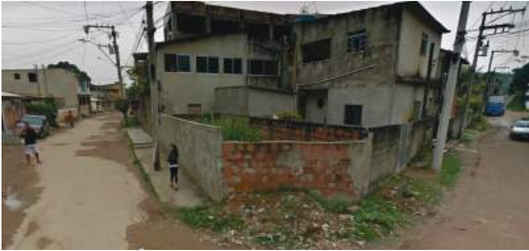
Figura 54: Bairro com pavimentação precária desprovido de sistema de drenagem – Parque Imperador - UP3 - Bacia do Roncador ou Santo Aleixo – Magé.
