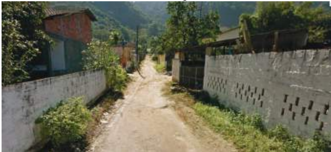
Figura 52: Bairro não pavimentado desprovido de sistema de drenagem – Gandê - UP3 - Bacia do Roncador ou Santo Aleixo – Magé.
