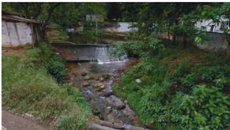
Figura 66: Vias pavimentadas e edificações a distancia inferior a 5 metros do Rio do Ouro, Rua Casimiro de Abreu – UP2 - Bacia do Suruí- Magé.
