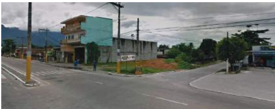
Figura 62: Bairro com pavimentação e drenagem por boca de lobo – Maurimácia – UP1 - Bacia dos Rios Estrela, Inhomirim, e Saracuruna – Magé.
