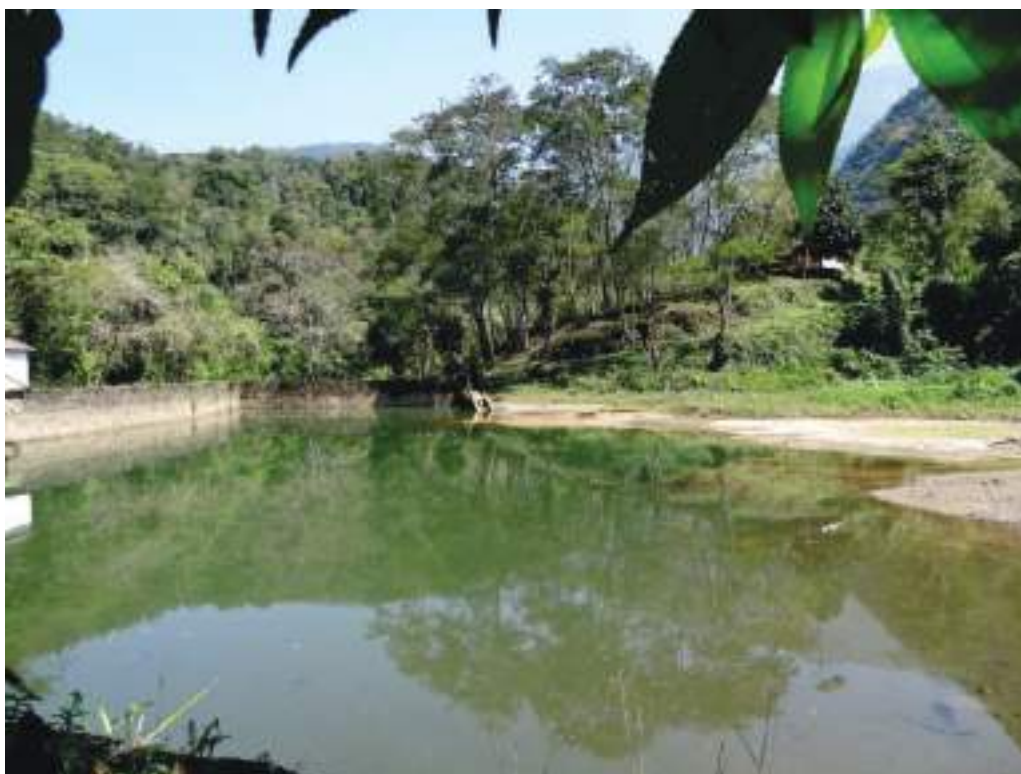
Figura 35: Reservatório de Pau a Pique em Santo Aleixo assoreado em mês de estiagem.
