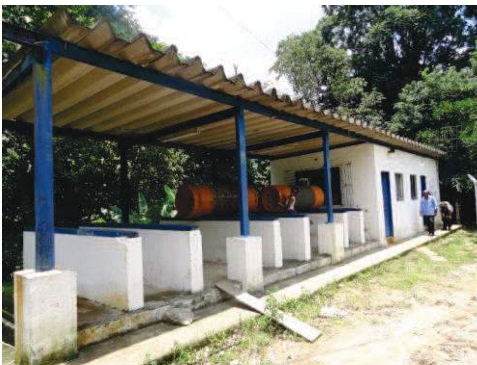
Figura 24: UT Sistema Piabetá – Casa de cloração e laboratório
