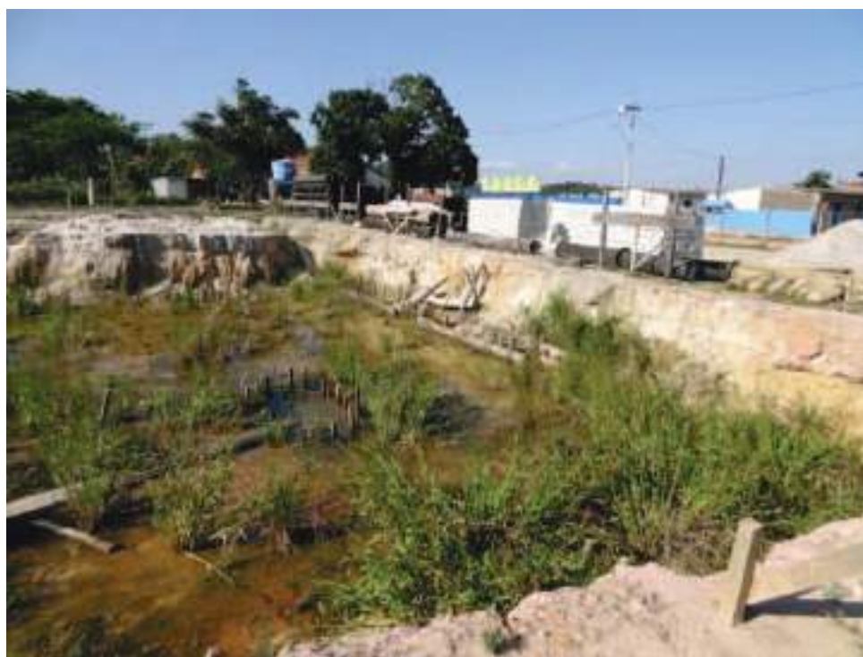
Figura 33: Local da ETA Sistema Roncador – CEDAE (out/2012)
