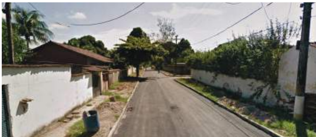
Figura 70: Bairro com poucas (20%) ruas pavimentadas e drenagem por grelha na sarjeta – UP4 - Bacia do Iriri- Magé.
