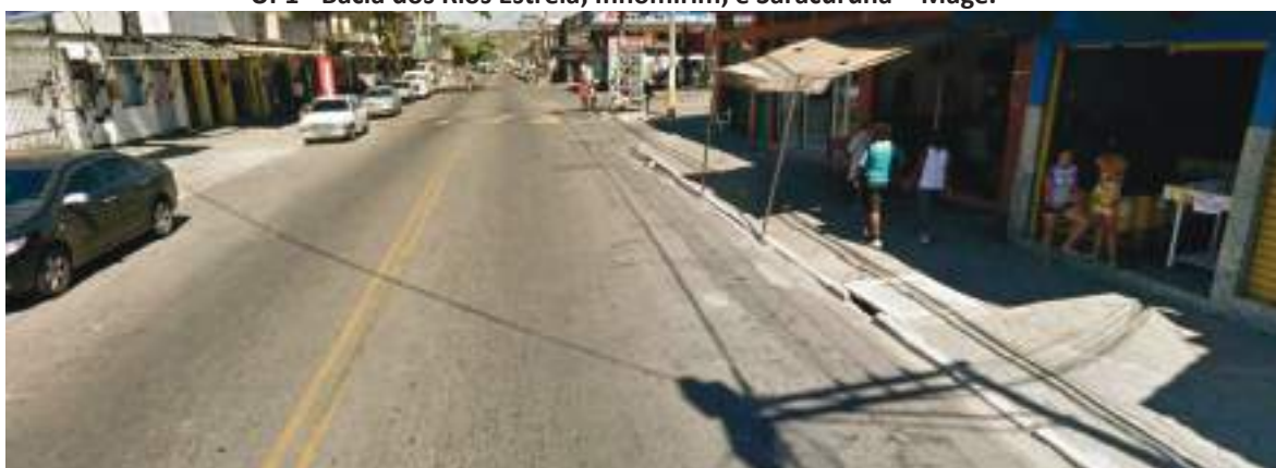
Figura 60: Bairro consolidado a partir da RJ 107, drenagem por boca de lobo – Fragoso – UP1 - Bacia dos Rios Estrela, Inhomirim e Saracuruna – Magé.
