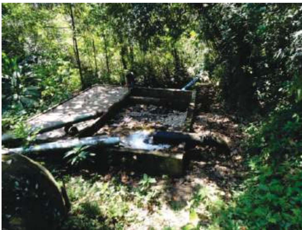
Figura 28: Gradeamento Sistema Santo Aleixo – CEDAE
