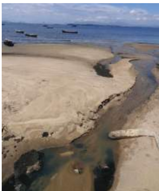
Figura 40: Rede mista desagua na praia de Olaria - "Língua Negra" em local de lazer.
