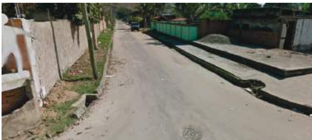
Figura 68: Bairro com pavimentação e drenagem por boca de lobo –Suruí - Magé UP2 - Bacia do Suruí- Magé.
