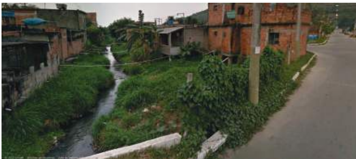
Figura 59: Bairro com pavimentação precária, drenagem por caixa com grelha na sarjeta – Sem Terra – UP1 - Bacia dos Rios Estrela, Inhomirim, e Saracuruna – Magé.
