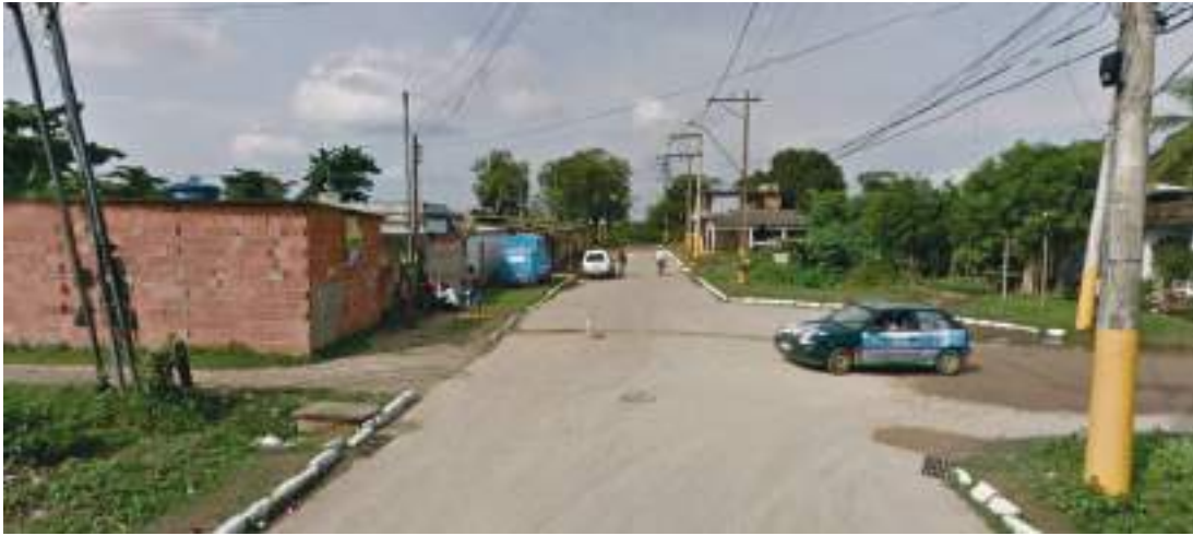
Figura 56: Bairro com pavimentação precária desprovido de sistema de drenagem – Barbuda - UP3 - Bacia do Roncador ou Santo Aleixo – Magé.
