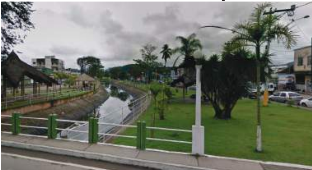
Figura 55: Canal de Magé com sistema de drenagem subterrânea desaguando em seu curso – Região Central - UP3 - Bacia do Roncador ou Santo Aleixo – Magé.
