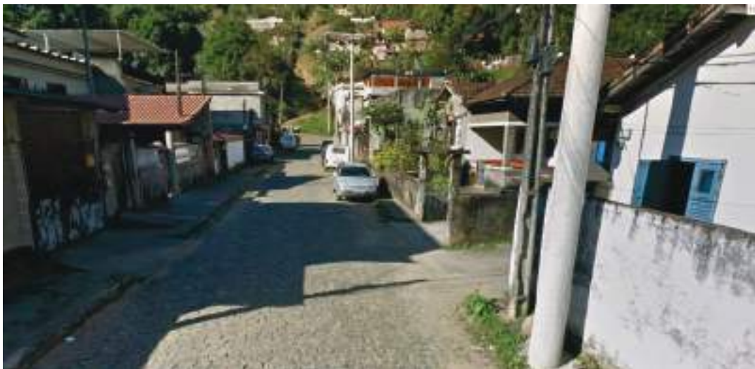
Figura 50: Vias com calçamento tipo paralelepípedo em terreno com declividades aproximadas 15% – UP3 - Bacia do Roncador ou Santo Aleixo – Magé.
