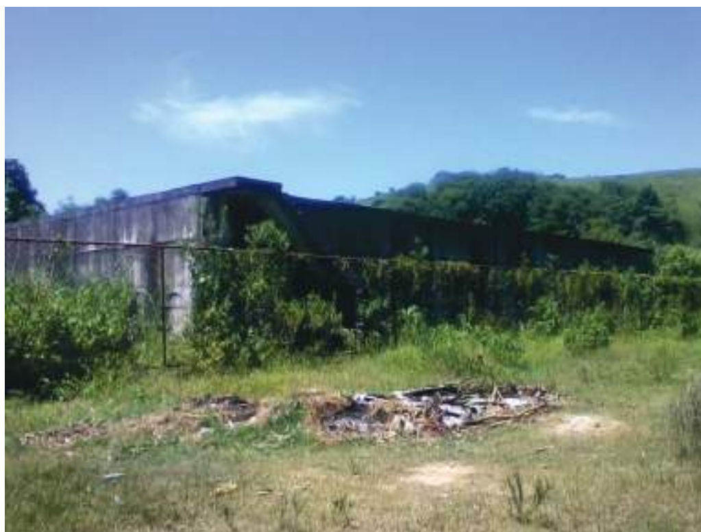
Figura 37: Estação de Tratamento de Esgoto Lagoa – Inativa
