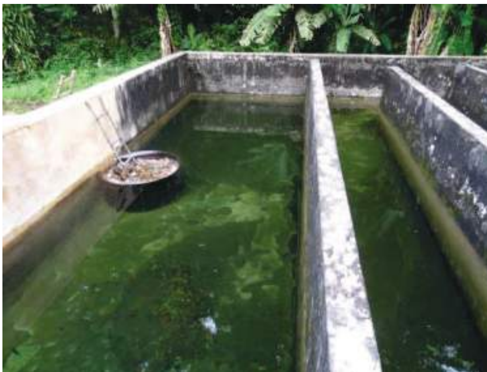
Figura 19: Tanque desarenador - Sistema Paraíso (CEDAE)
