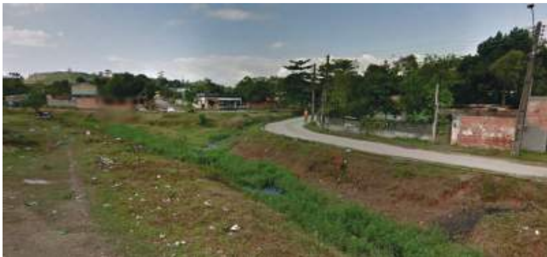
Figura 53: Bairro com pavimentação precária desprovido de sistema de drenagem – Nova Marília- UP3 - Bacia do Roncador ou Santo Aleixo – Magé.
