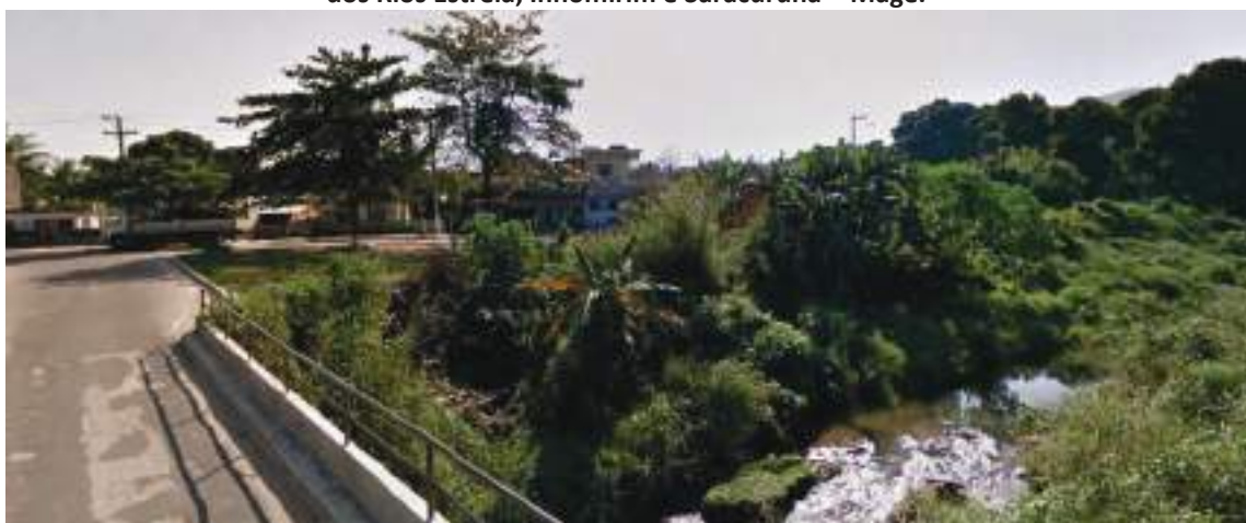
Figura 61: Ponte sobre Rio Caiobá Mirim, em processo erosivo por perda de mata ciliar – bairro com drenagem por grelha com ocorrências de enchentes – São Sebastião – UP1 - Bacia dos Rios Estrela, Inhomirim e Saracuruna – Magé.
