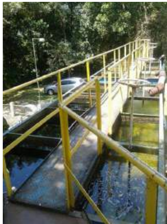
Figura 15: ETA Sistema Rio Soberbo – vista superior dos filtros.
