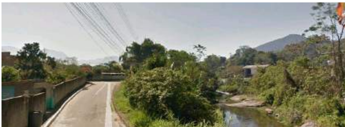
Figura 27: Drenagem superficial do Bairro Parada Modelo Rua Beira Rio – vias e edificações ao longo do Rio Bananal.
