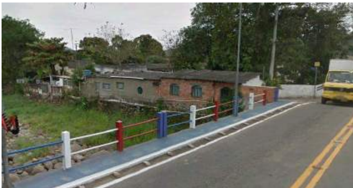
Figura 30: Ponte sobre o rio afluente do Rio Soberbo – Bairro Espinhaço – vias e edificações ao longo do curso d'água.
