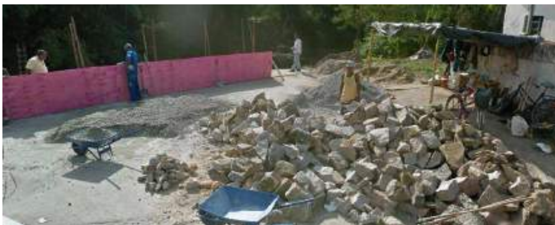
Figura 31: Margem de afluente do Rio Soberbo no bairro Segredo – vias e edificações ao longo do curso d'água.
