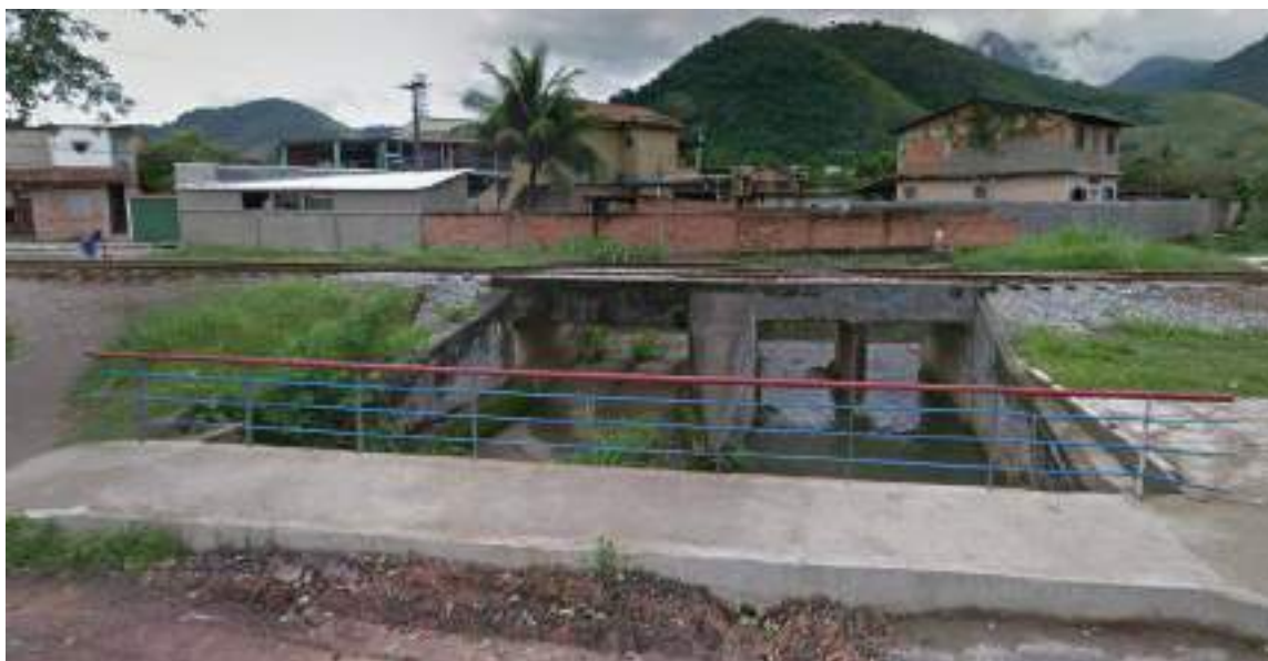
Figura 28: Drenagem superficial do Bairro Parque Freixal - Rua Vereador Moacyr Pimentel – vias e edificações ao longo do Riacho Branco.
