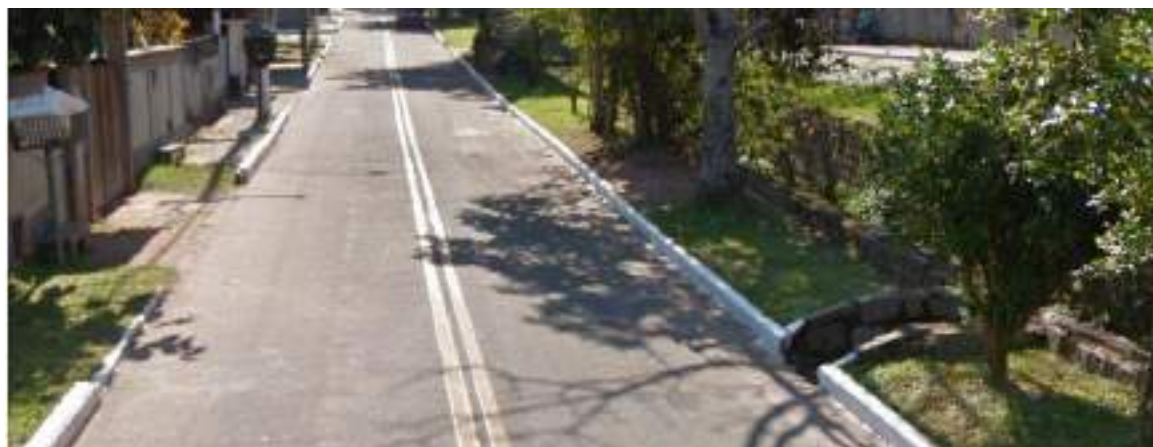
Figura 29: Drenagem superficial do Bairro Paiol - Rua Abigail Pereira – vias e edificações ao longo do Riacho Branco.
