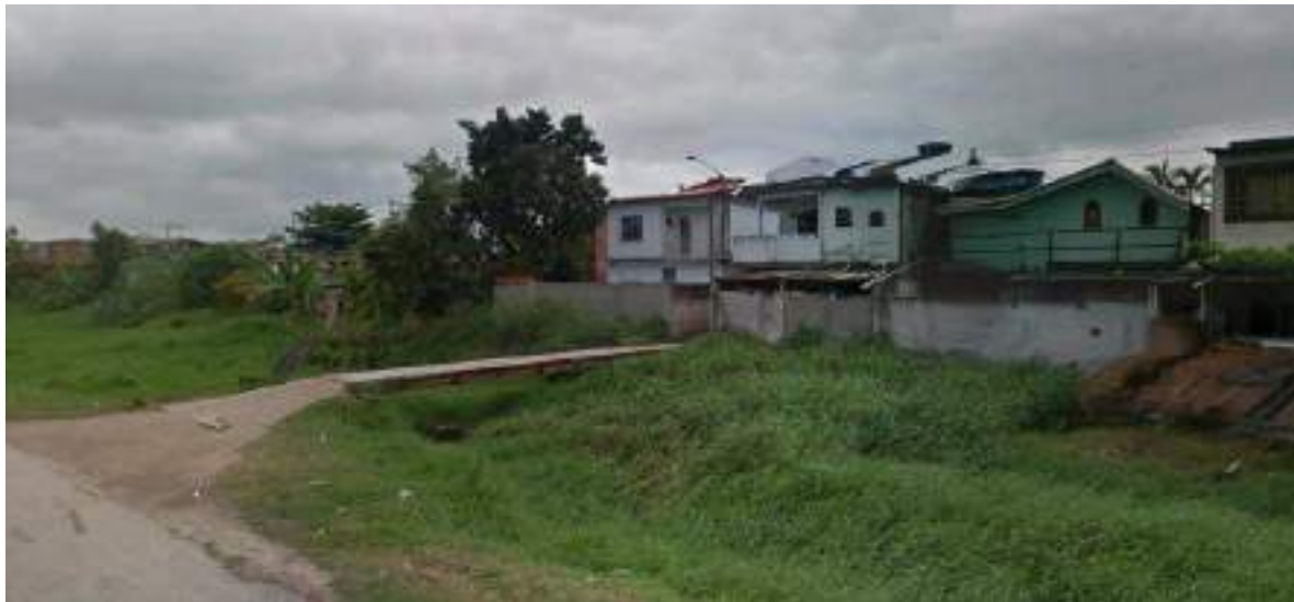
Figura 24: Bairro de Vila Olímpia em Guapimirim - casas às margens do Canal de Magé.
